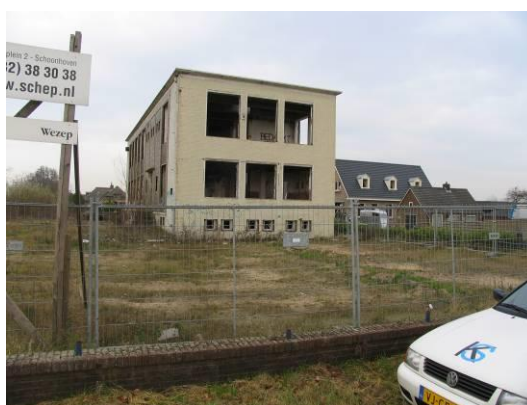
Huidige 'karkas' voorm. bedrijfsgebouw
