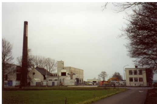
Foto van het voormalige fabrieksterrein
