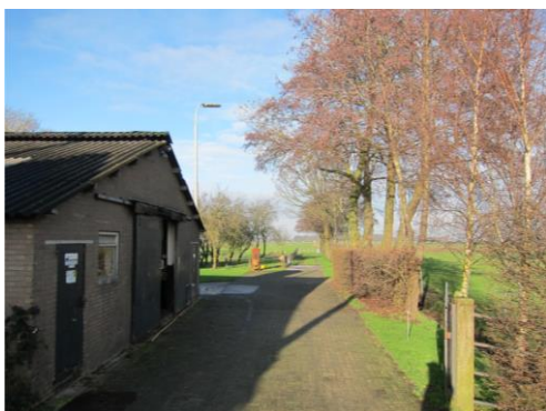
Foto bestaande opstallen
