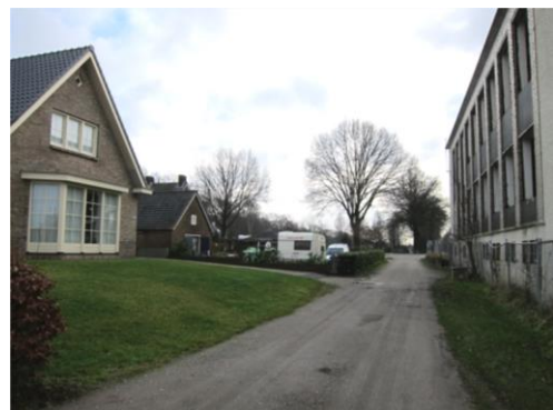
Foto oprit richting weg
