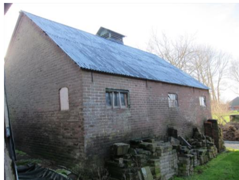
Foto bestaande opstallen
