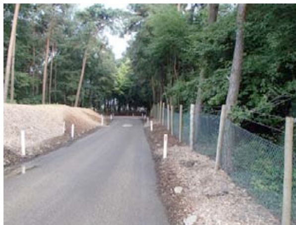
ontsluitingsweg richting de Bovendwarsweg met geluidwal en hekwerk
