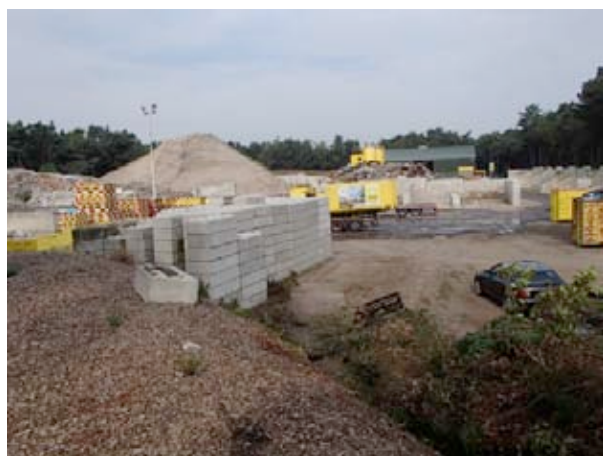
overzicht terrein vanuit het zuiden met sorteerhal en puinberg
