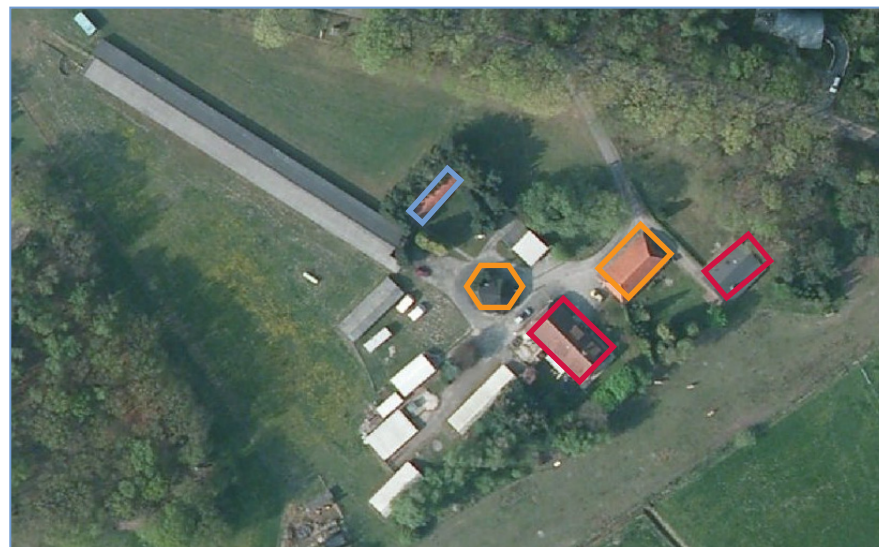
De locatie: in rood de woningen, in oranje de schuur met maatschappelijke bestemming en de hooiberg achter de boerderij. In blauw de recreatiewoning. Overige gebouwen zijn schuren.
