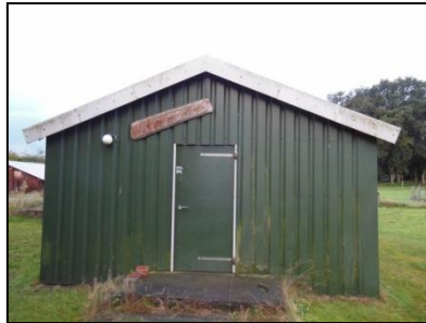
Figuur 7. Te slopen bebouwing.
