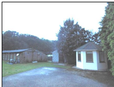
Figuur 4. Te slopen bebouwing.
