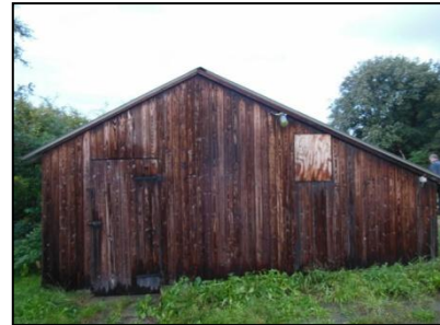
Figuur 8. Te slopen bebouwing.
