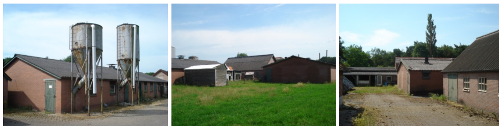
Foto's: De te slopen opstallen.
