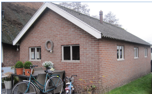
Het bakhuisje naast de boerderij is een kenmerkend element bij een boerderij. Het bakhuisje is geheel verbouwd met nieuwe muren, dak en verlengd aan de achterzijde. Binnen is nog wel de oude schoorsteen te herkennen.
