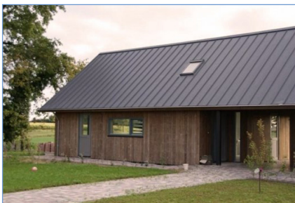
Schuurwoning met eenvoudige uitstraling.
