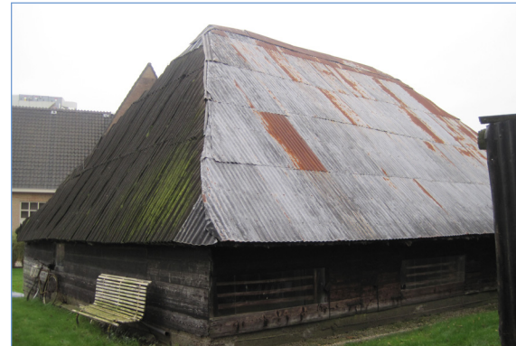
De karakteristieke houten schuur achter de boerderij. Onder de golfplaten zit nog de rieten kap.
