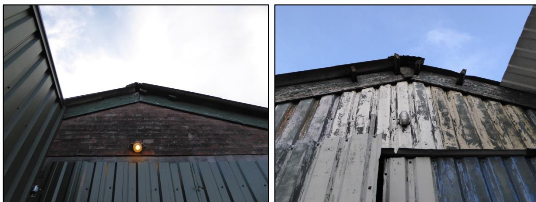
Links: houten daklijst aan voorkant van schuur 1. Rechts: houten daklijst aan achterkant van schuur 1.
