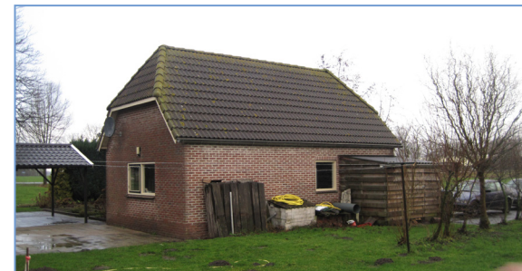
Het bestaande bijgebouw op nr. 74A. Deze is 50m2 groot en geeft een beeld van de maat van de nieuwe bijgebouwen.
