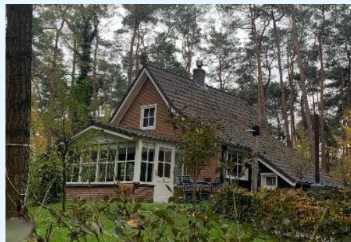
figuur 10: Ottenweg 63, noord- en oostgevel
