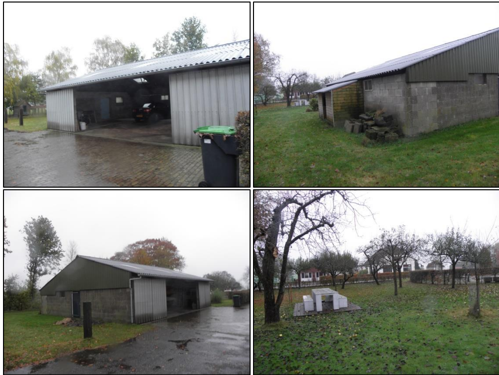
Impressie van de af te breken werktuigenschuur met het omliggende grasveld
