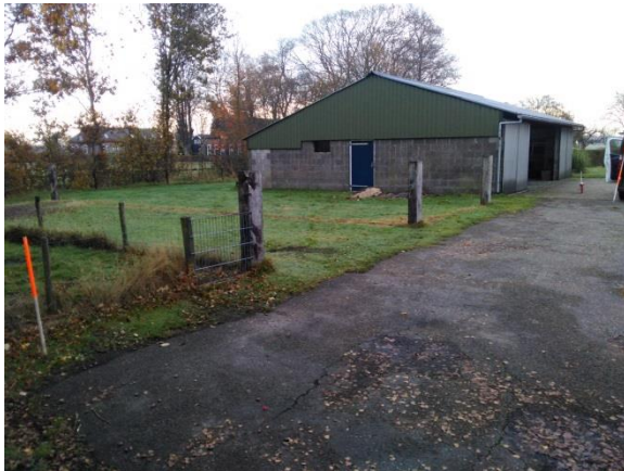
Figuur 8: Overzichtsfoto bebouwing
