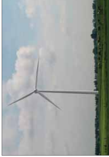
Afb.1: Windturbine: ashoogte 105 m, rotordiameter 90 m.
