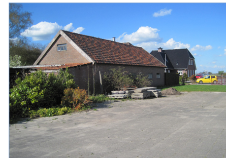
Het erf grenst aan de noordzijde ook aan andere erven.
