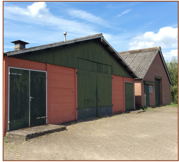
Afb. 2.3: Gebouw D en E. Foto genomen vanaf de Duivendansweg.
