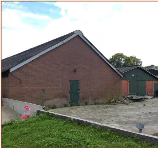
Afb. 2.2: Gebouw D (rechts) en E (links) vanaf de achterzijde gezien.
