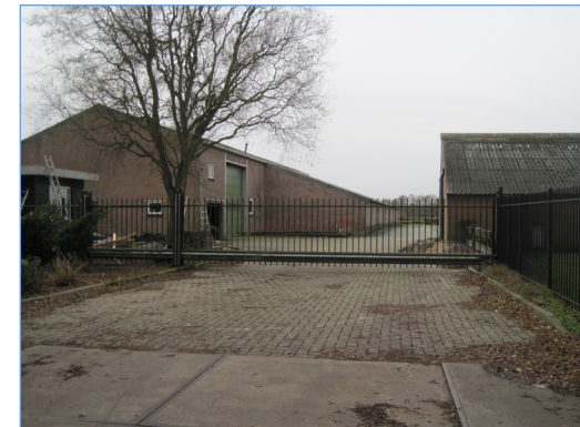
Het erf vanaf de hoofdentree. Links de grote schuur met opvallende hoge entree. Rechts de kleine veeschuur.
