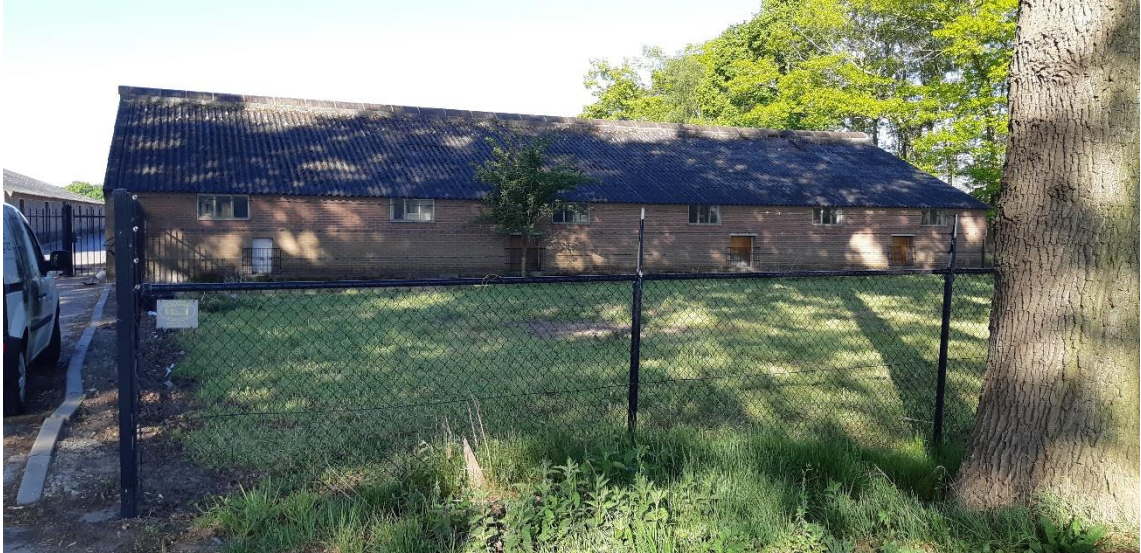
Figuur 1.2 De kleine schuur vanaf de weg gezien.
