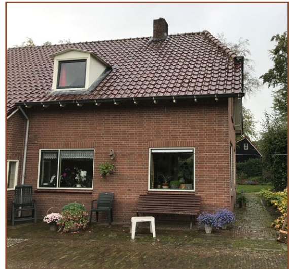
Afb. 2.3: Beeld van de woning, strak afgewerkt, zonder toegankelijke openingen, gaten en kieren.
