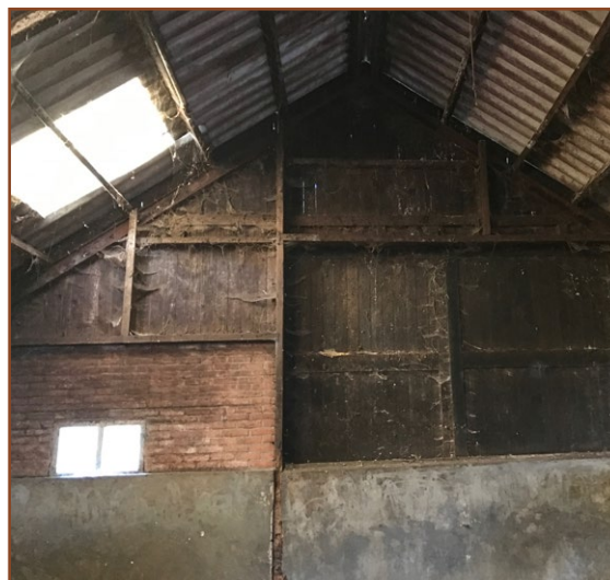
Afb. 2.5: De veeschuur aan de binnenzijde met de onafgetimmerde wanden en dakplaten.
