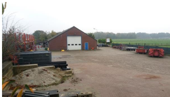
Foto 3: Op de achtergrond de loods, op de voorgrond opslag van bestratingsmaterialen.
