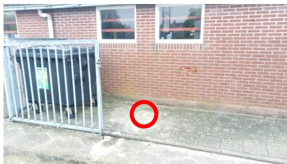
Foto 7: Aan de buitenzijde van de olieopslag is een peilbuis geplaatst (in de rode cirkel).
