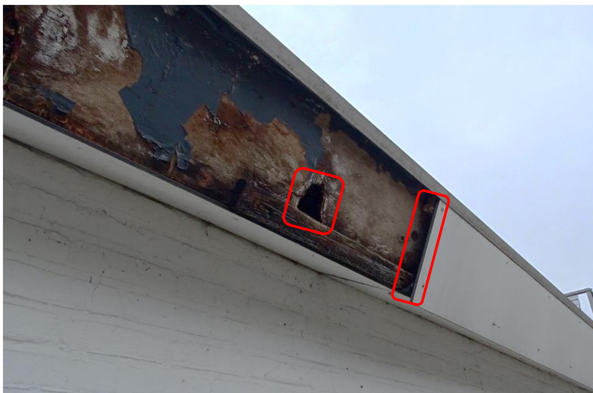
Figuur 5.5. Invliegopeningen voor vleermuizen in de gaten in de houten betimmeringen en achter de boeiranden.
