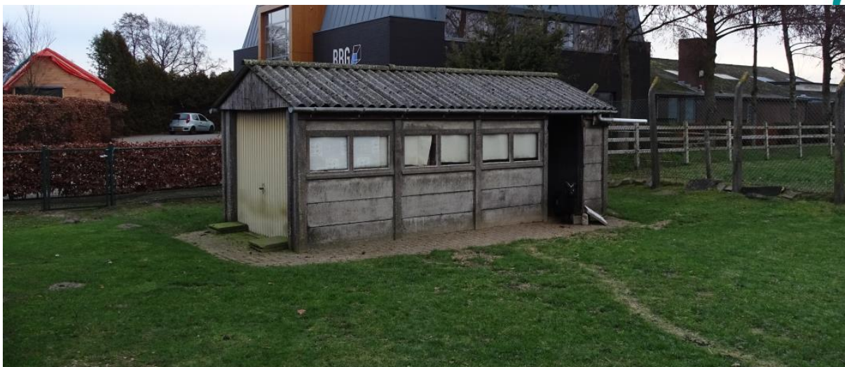
Figuur 2.6. Schuur die momenteel in gebruik is als onderkomen geiten en kippen, gezien in oostelijke richting.
