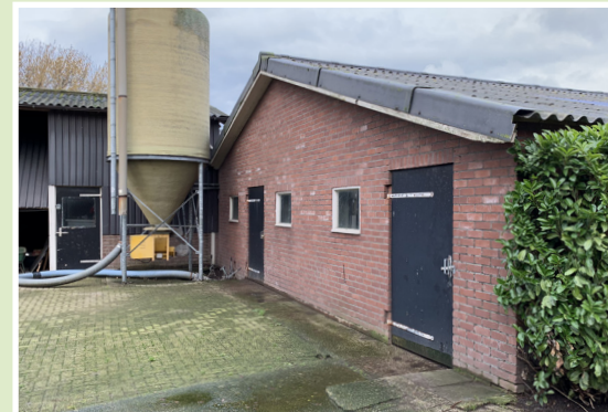
Opslag materieel, enkele struiken en installaties (D)
