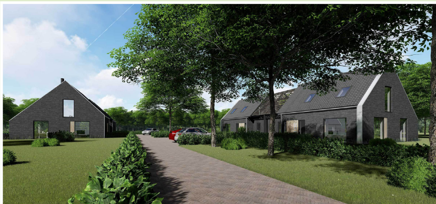
oprit die toegang biedt tot achtergelegen erf
