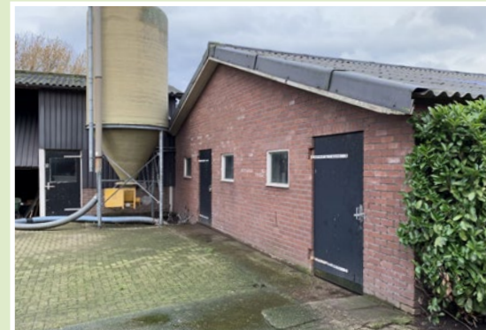
Opslag materieel, enkele struiken en installaties (D)
