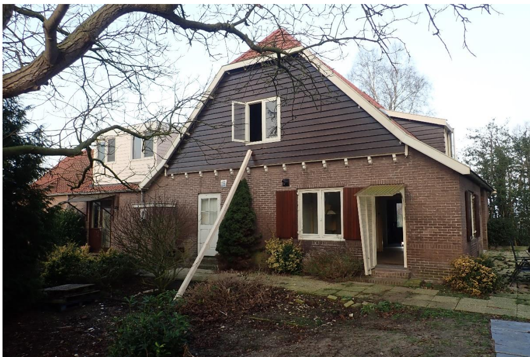
Figuur 2.2. voorzijde woningdeel nr 439a (zuidoostelijke gevel)
