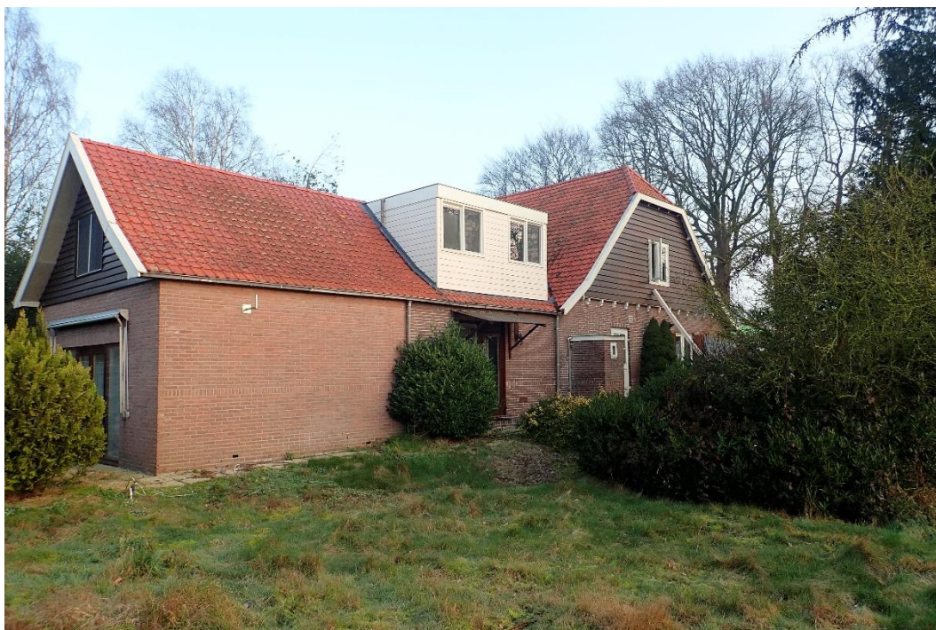
Figuur 2.5. voorzijde woningdeel nr 439 (zuidwestelijke gevel)
