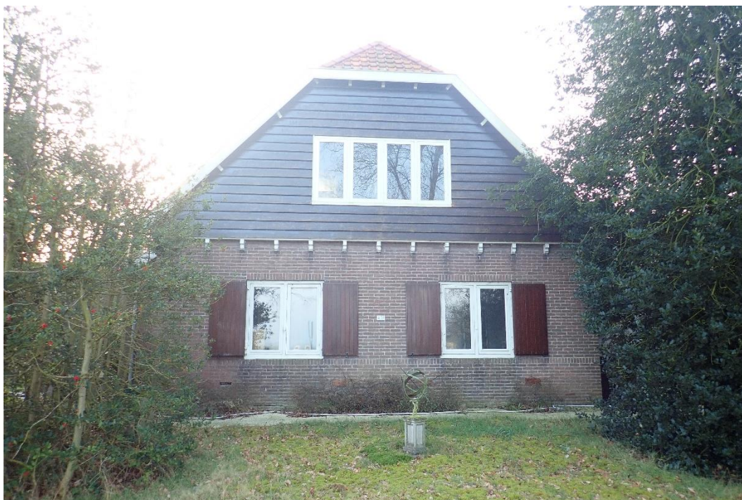
Figuur 2.4. achterzijde woningdeel nr 439a (noordwestelijk gevel)
