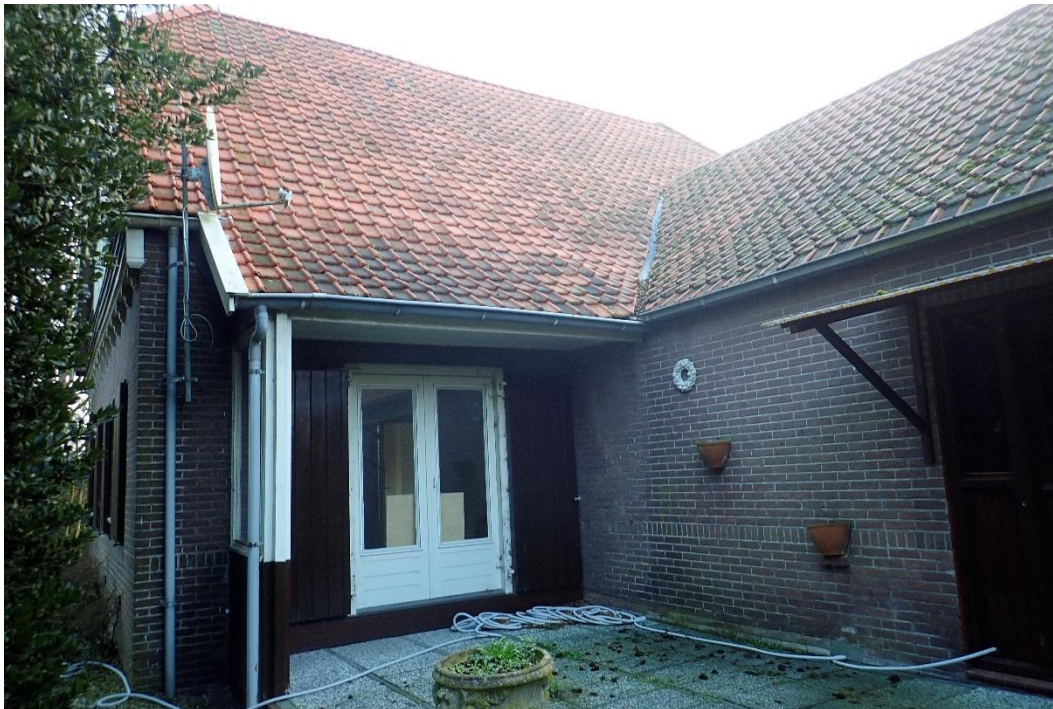
Figuur 2.6. achterzijde woningen met aansluiting tussen de woningdelen. Links: 439a, rechts: 439.
