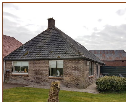
Afbeelding 4: De te slopen woning gezien vanuit noordoostelijke hoek.
