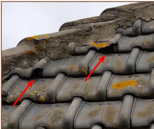
Afbeelding 6: Voor vleermuizen geschikte openingen in de dakconstructie.
