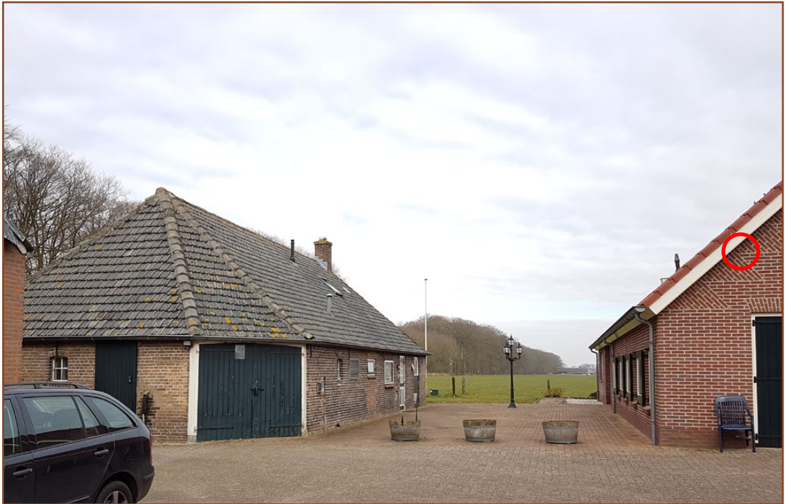
Afbeelding 5: Beide woningen gezien vanuit zuidoostelijke richting, met links de te slopen woning en rechts de te behouden boerderijwoning waaraan geen ingrepen zullen plaatsvinden. Rood omcirkeld de aangetroffen verblijfplaats van gewone dwergvleermuis.
