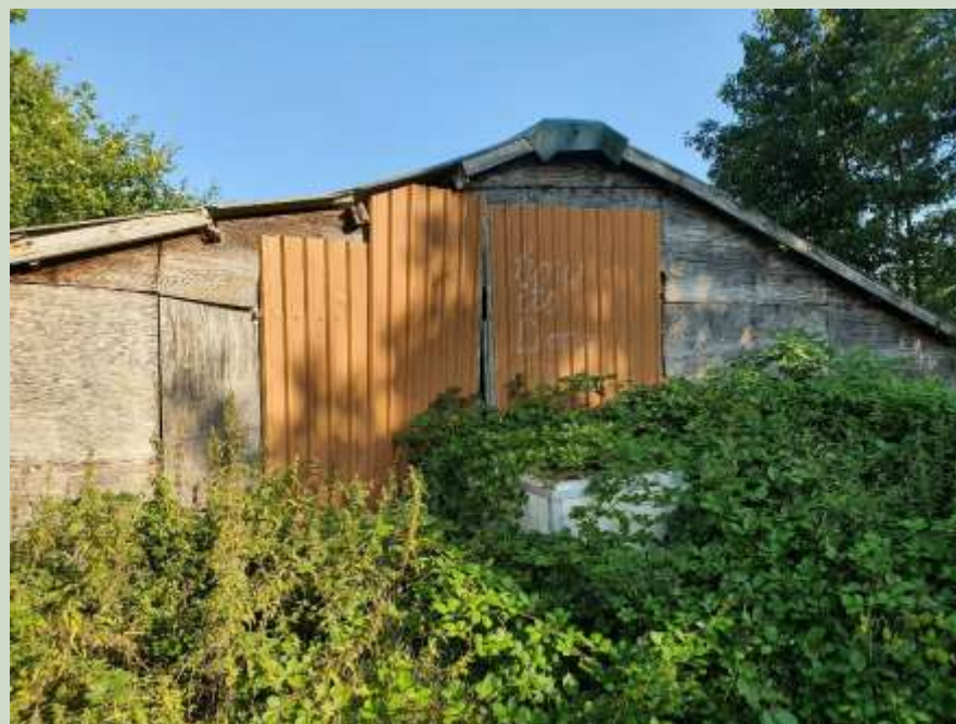
Te slopen bebouwing
