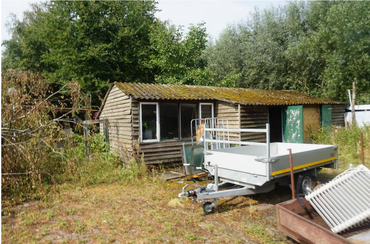
Figuur 2.4 Overzichtsfoto van een van de te slopen schuren, gezien vanuit zuidoostelijke richting.
