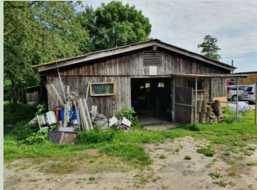
Te slopen bebouwing
