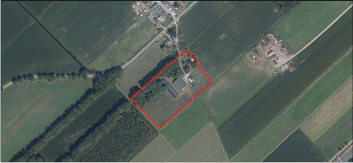
Afbeelding 2.2 Luchtfoto huidige situatie plangebied (Bron: PDOK)
