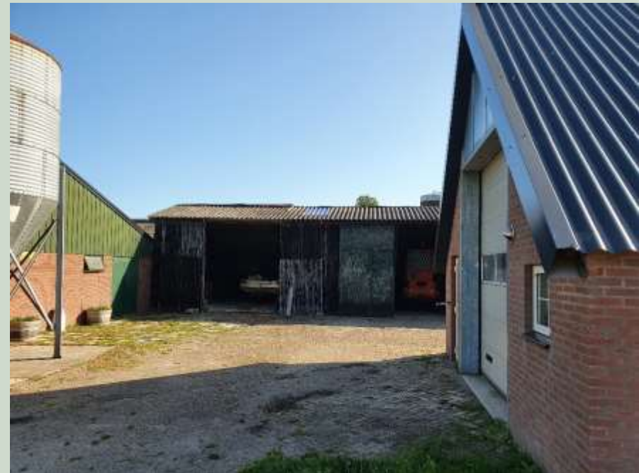
Te slopen stal / kapschuur
