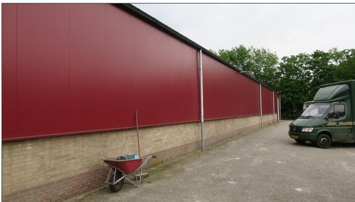
Figuur 2 De binnenbak is opgebouwd uit bakstenen muren zonder luchtsponw. Deze wordt vanaf één meter hoogte omhuld door metalen damwandplaten.
