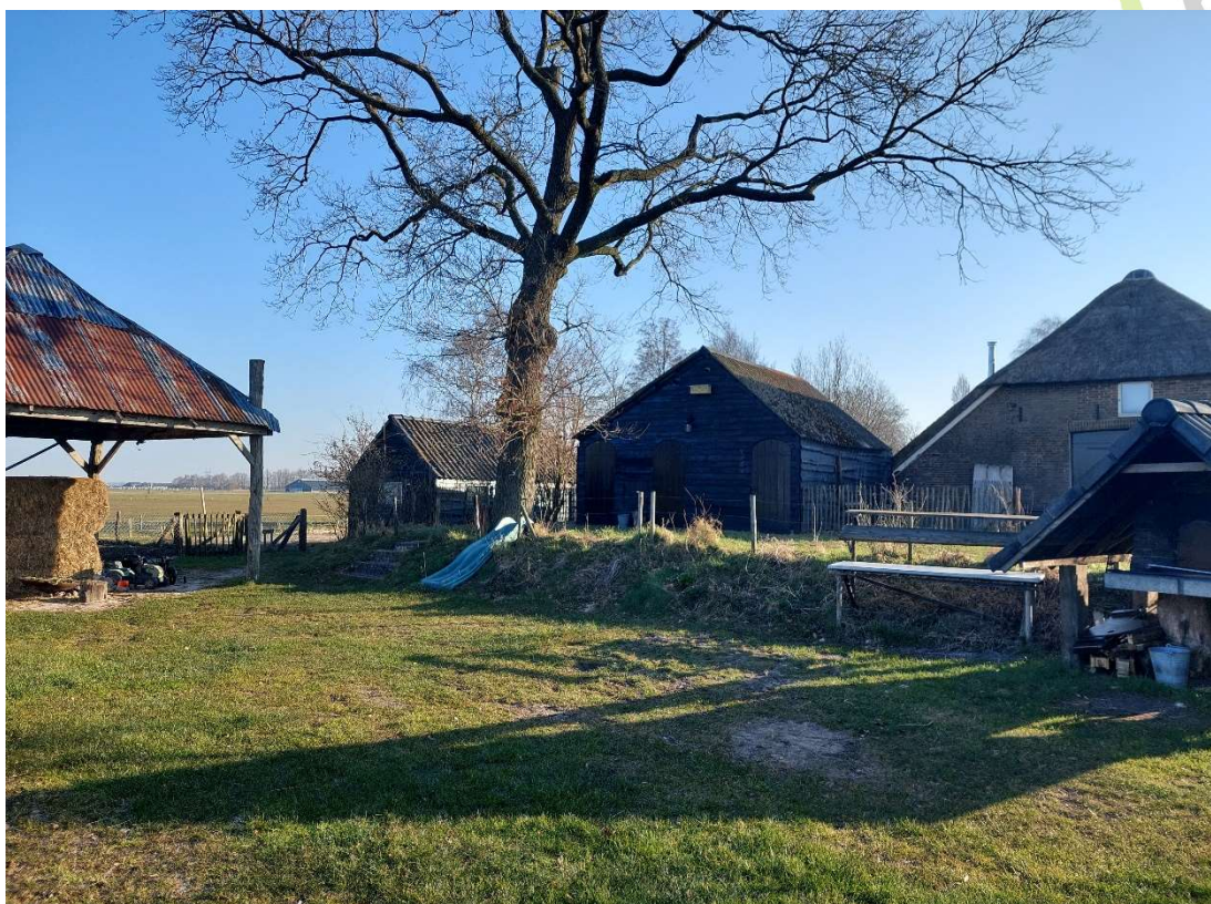
De opstallen op de verhoging vallen buiten het plangebied en zijn niet in deze quick scan beoordeeld. Foto: C. Fokker | Ecoresult B.V.
