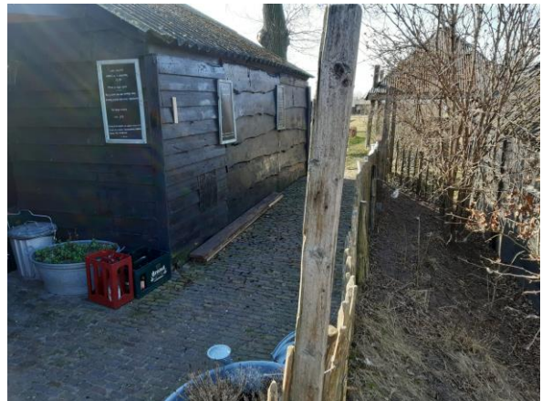
Foto 4: Drupzone noordzijde schuur (campingwinkel) met onderliggende klinkers, gezien in westelijke richting
