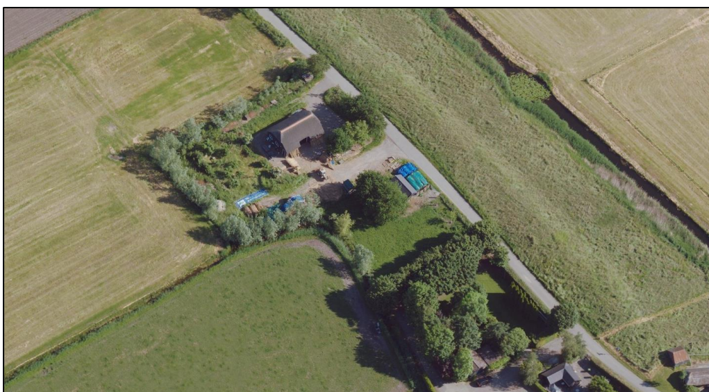
Bestaande situatie, plangebied gezien vanuit het zuiden (bron: VanWestreenen).
