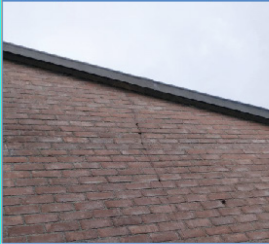
Afbeelding. 4.1: Zuidelijke zijde van de te slopen rundveestal. In de rand is nestmateriaal aangetroffen van huismus.
