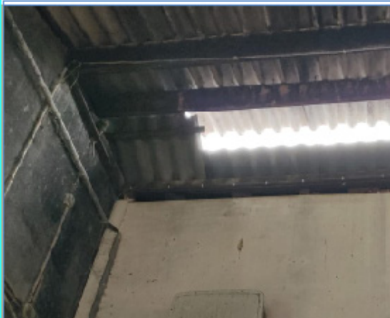
Afbeelding. 4.5: Noordelijke binnenzijde van de te slopen rundveestal.
