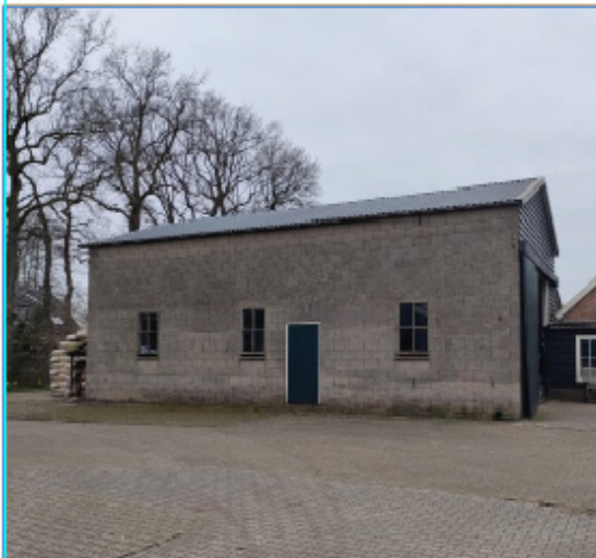
Afbeelding. 4.9: Zuidelijke zijde van de te slopen schuur 2.
