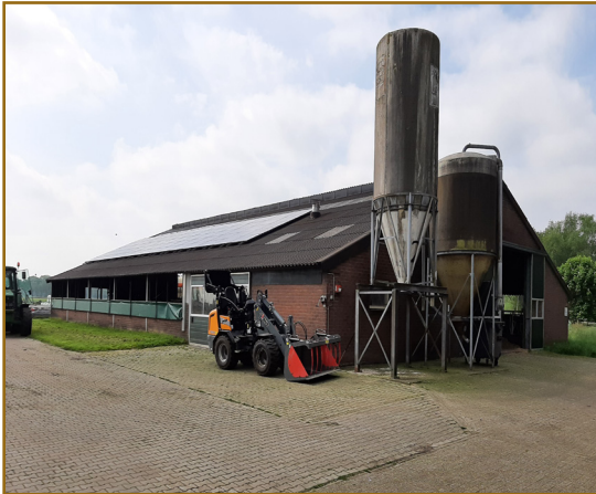
Afbeelding 4: De te slopen stal waarin vier huismusnesten zijn aangetroffen. Door de sloop gaan de nesten verloren.
