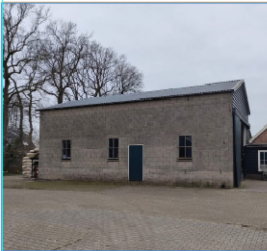
Afbeelding. 4.9: Zuidelijke zijde van de te slopen schuur 2.
