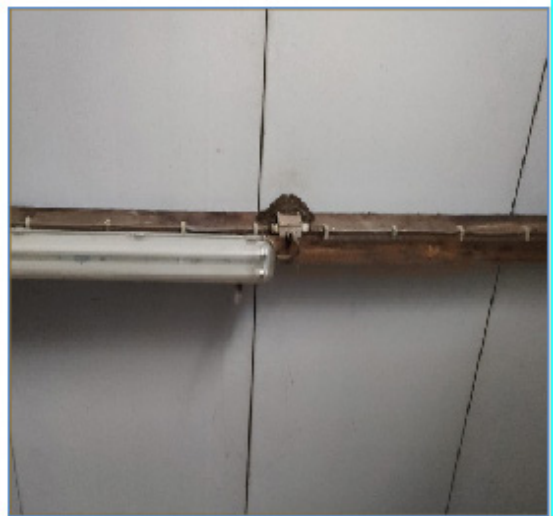
Afbeelding. 4.8: Binnenzijde van de te slopen schuur 2. Op de verbindingsdoos is een nest van boerenwaluw aangetroffen.
