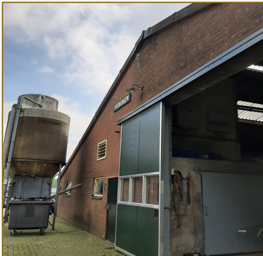
Afbeelding 6: Noordelijke kopgevel te slopen stal. Hier werden twee nestplaatsen van huismus en één nestplaats van spreeuw aangetroffen.
