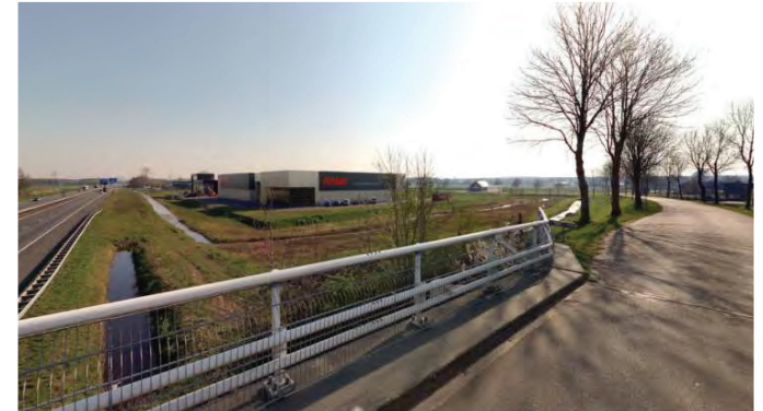
Huidige zicht vanaf Voskuilerdijk op A28 en plangebied
