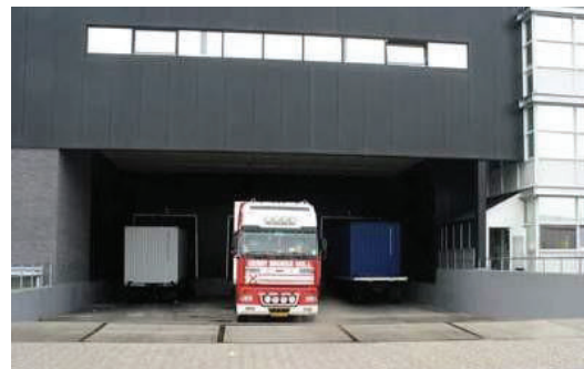
Loading docks onderdeel architectuur
