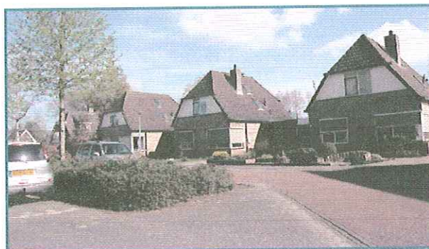
Zicht over parkeerplaats naast projectlocatie op woningen Lage Weide 24, 26 en 28 (vlnr)
