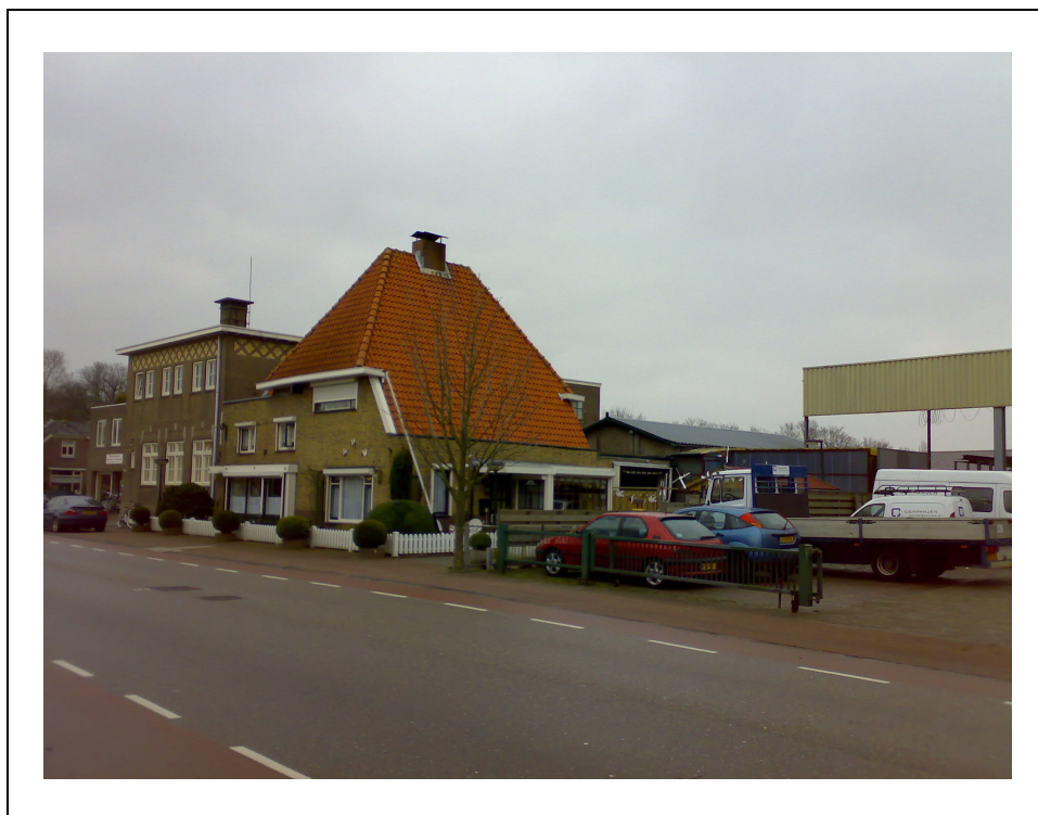
Figuur 3.3: Zicht op twee gebouwen, gelegen ten oosten van het metaalbedrijf. Deze woningen worden ingepast in het plangebied (gefotografeerd vanuit de Zuiderzeestraatweg richting het zuidoosten).
