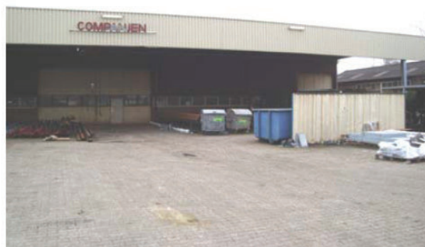
Foto 2: Centrum plangebied met gebouw 4 (fig.3).
