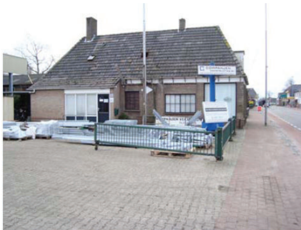
Foto 1: Entree plangebied met gebouw 1 (fig.3).
