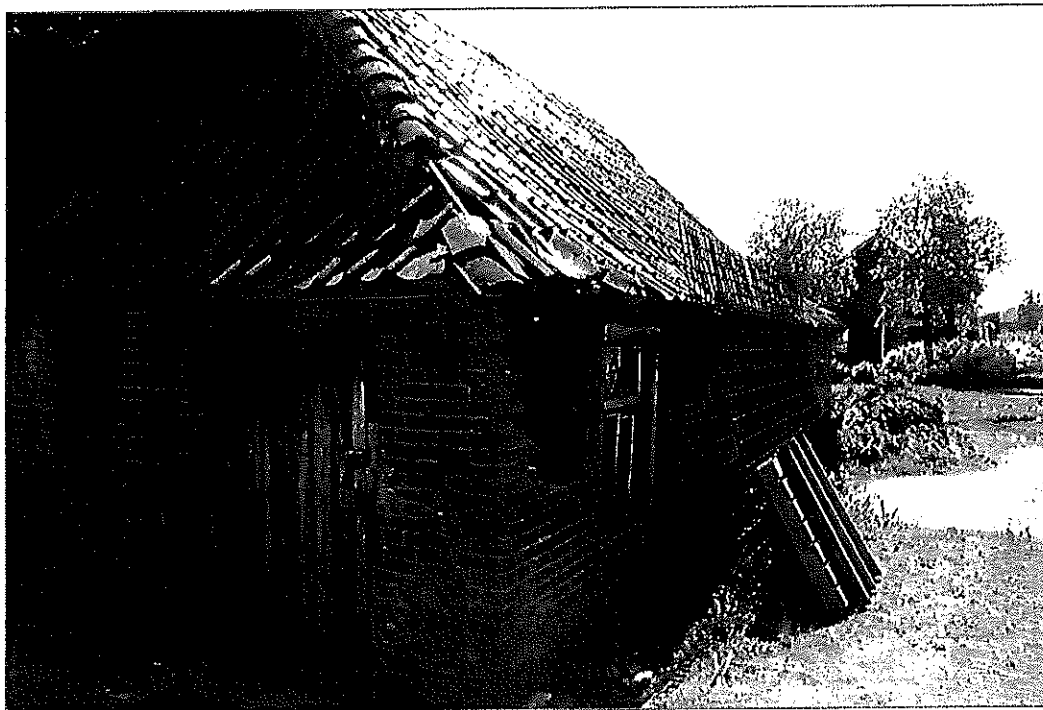
Foto 2. Overzicht van het plangebied met links de vervallen stenen schuur
