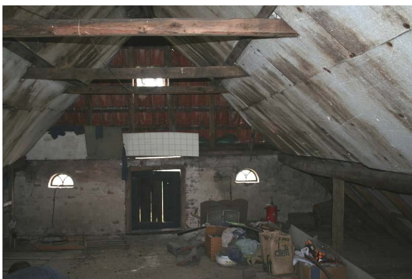
Zolder met open ramen waar vliedervleugels zijn aangetroffen.
