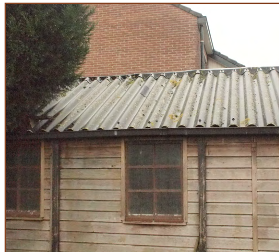
Afb. 5: Werkschuur in de zuidwesthoek van het plangebied. Op de achtergrond de zijgevel van het naastgelegen woonblok.
