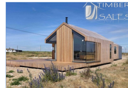
Voorbeeld van natuurlijk materiaal gebruik en moderne invulling van de traditionele hoofdvorm.
