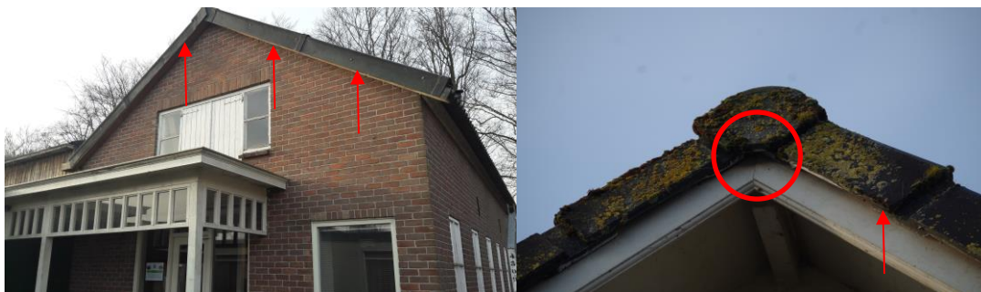
Figuur 4.1 Potentiële verblijfplaatsen vleermuizen in de vorm van ruimte achter gevelbekleding en middels nok- gevelpannen.
