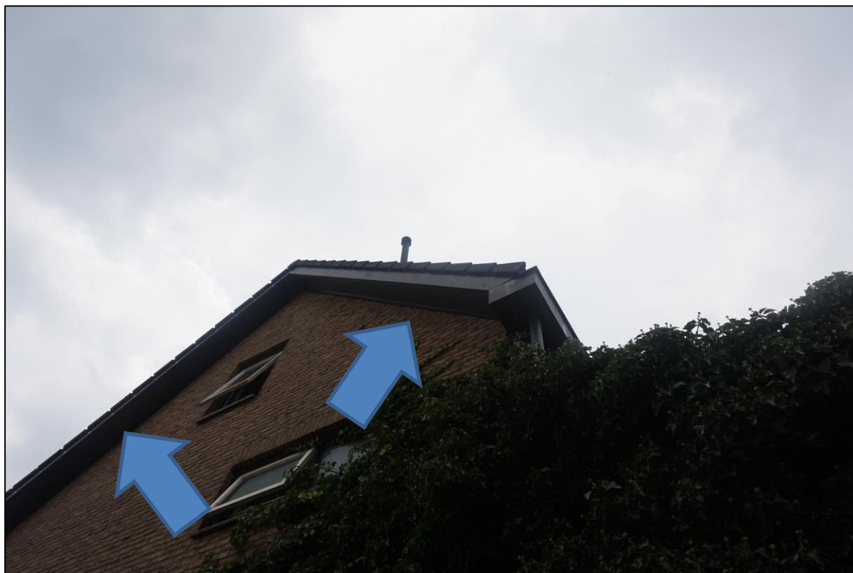
Figuur 4.4 Zijgevel woning. De pijlen markeren mogelijk toegang tot het dak gierzwaluw en vleermuizen.
