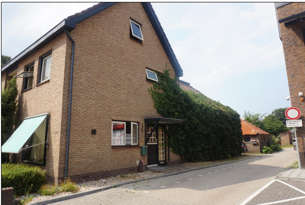
Figuur 1.3 Zijgevel woning Zuiderzeestraatweg 124 Oldebroek.
