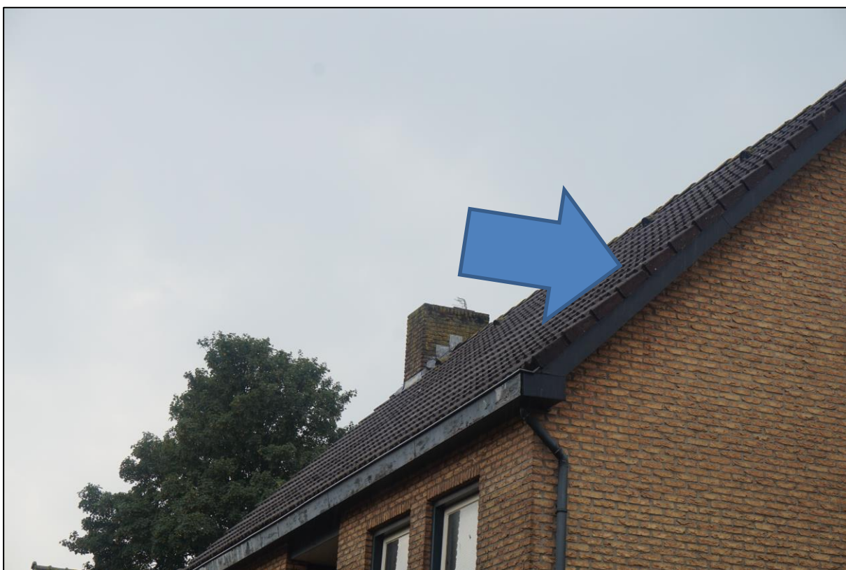
Figuur 4.3 Kantpannen zijgevel woning. De pijlen markeren mogelijk toegang tot het dak gierzwaluw en vleermuizen.
