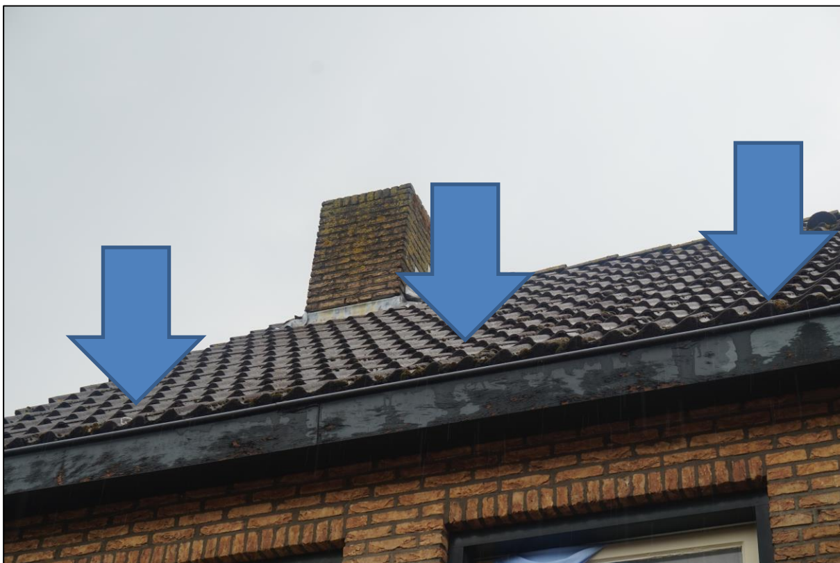
Figuur 4.2 Dakrand aan voorgevel woning. De pijlen markeren mogelijke toegang tot de onderste rijen dakpannen voor huismus en gierzwaluw.
