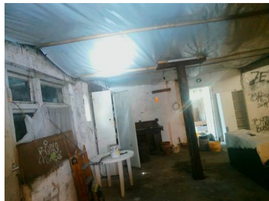
boven plastic plafonds originele verdiepingsvloeren
