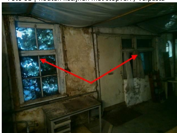
Foto 63 | houten kozijnen met stopverf / vulpasta
