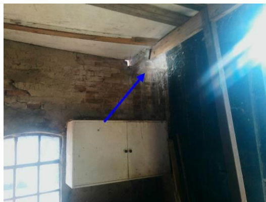
rookkanaal schuur 3 niet asbestverdacht gemetseld
