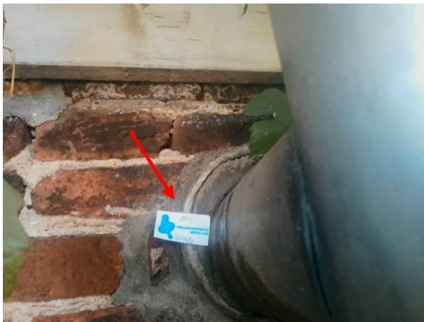
Foto 49 | buis in gevel
