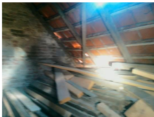
inboedel schuur 3 geen asbestverdachte materialen
