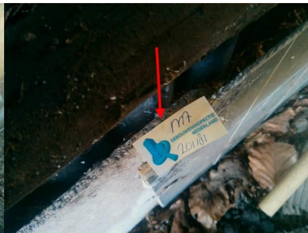
Foto 31 | restanten plaat ingegraven
