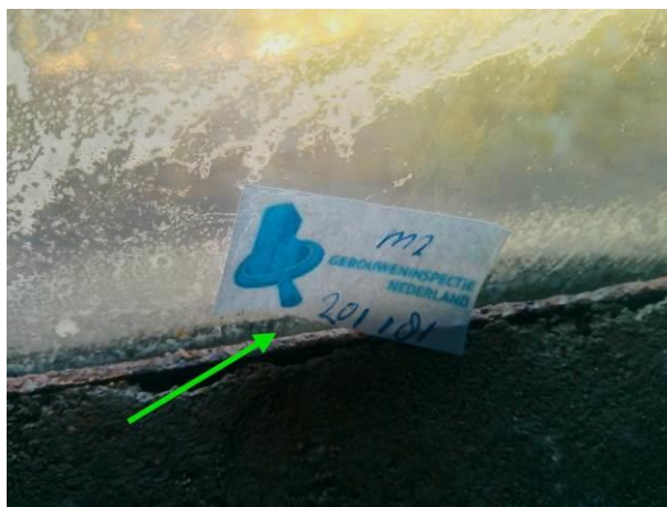
Foto 12 | stopverf / vulpasta in stalen ramen
