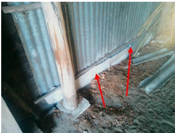
Foto 30 | restanten plaat ingegraven
