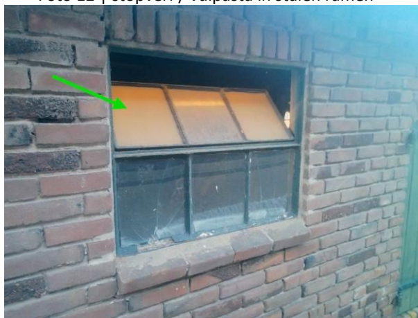
Foto 14 | stopverf / vulpasta in stalen ramen
