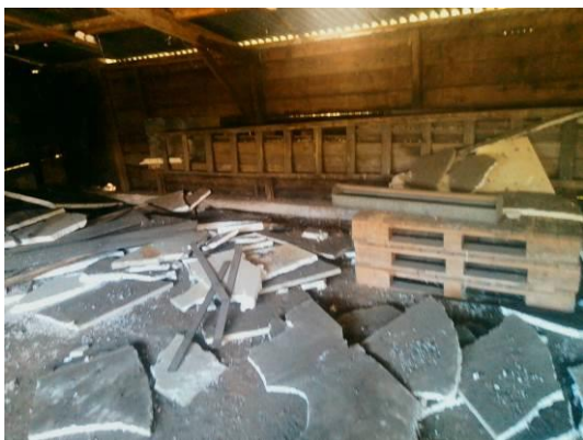
piepschuim in schuur 4 (voormalig dakbeschot)
