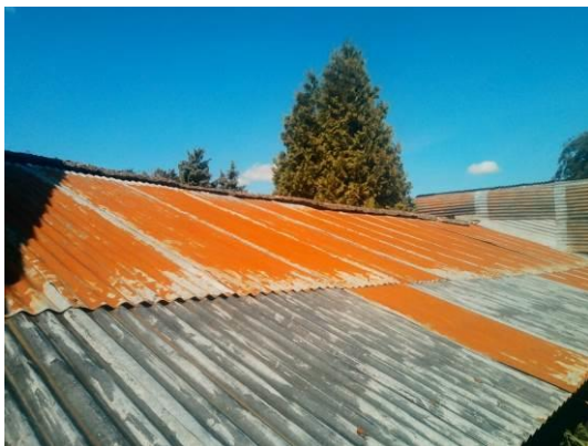
gedeelte dak schuur 4 blikken golfplaten
