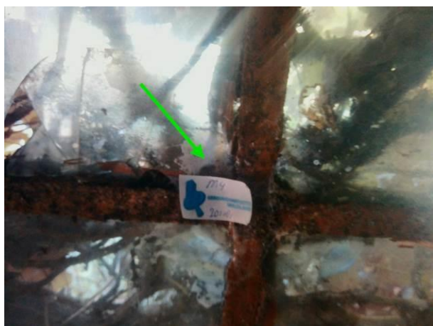
Foto 16 | stopverf / vulpasta in stalen ramen
