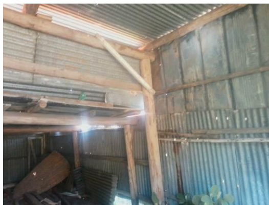
blikken golfplaten schuur 5
