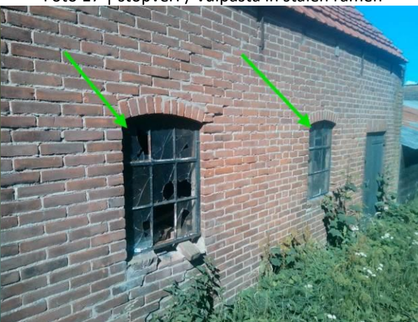
Foto 19 | stopverf / vulpasta in stalen ramen
