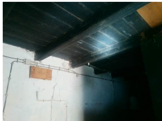
originele balklaag / verdiepingvloeren achterhuis
