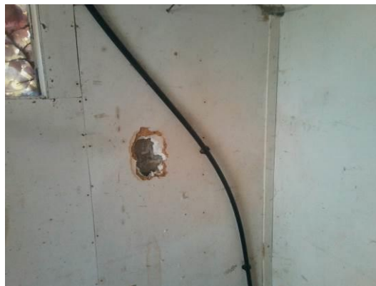
originele muren achter spaanplaat voorzetwanden
