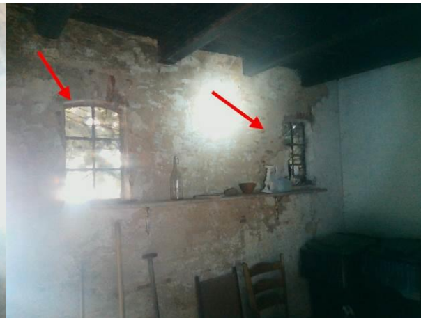
Foto 66 | stalen kozijnen met stopverf / vulpasta
