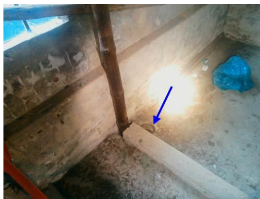
buis in vloer schuur 2 gres
