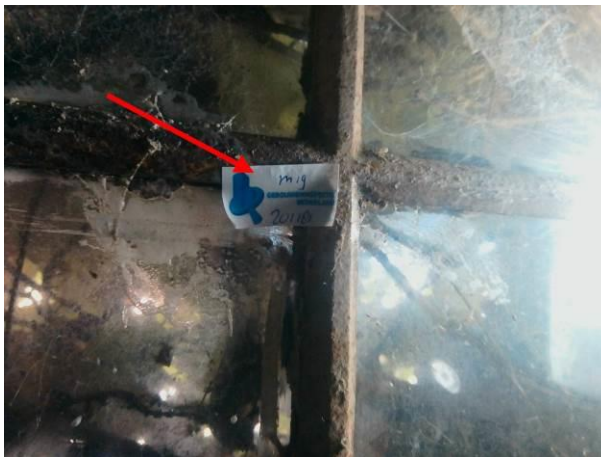
Foto 65 | stalen kozijnen met stopverf / vulpasta
