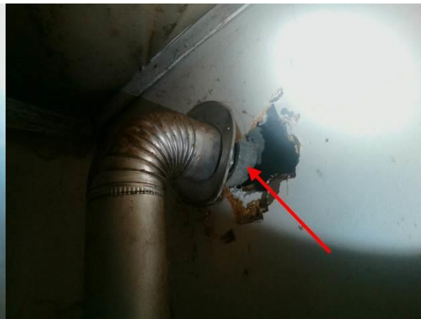
Foto 50 | buis in gevel
