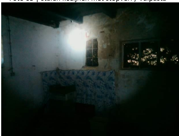
Foto 67 | stalen kozijnen met stopverf / vulpasta
