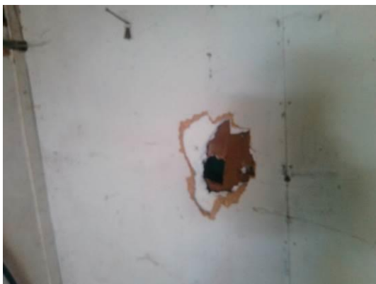
originele muren achter spaanplaat voorzetwanden
