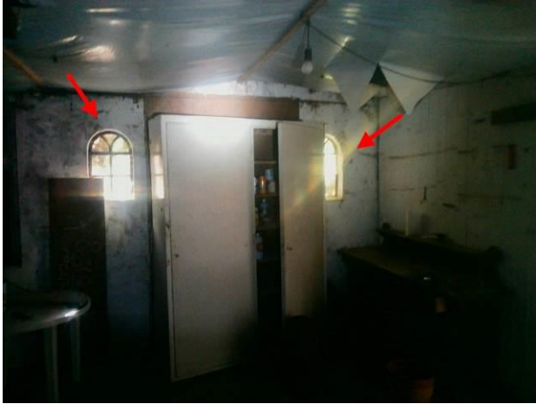
Foto 69 | stalen kozijnen met stopverf / vulpasta
