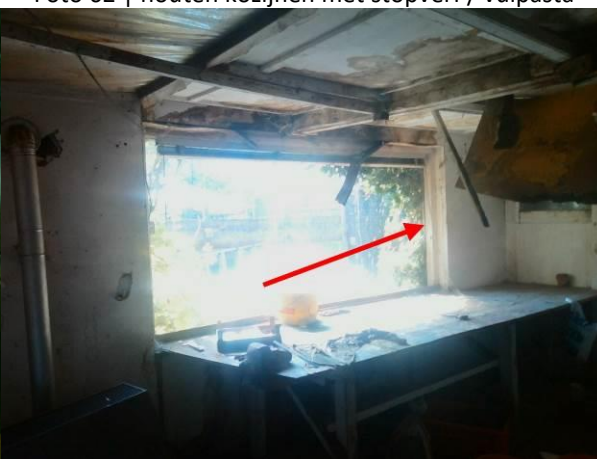
Foto 64 | houten kozijnen met stopverf / vulpasta
