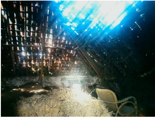
originele kapconstructie hout pannen
