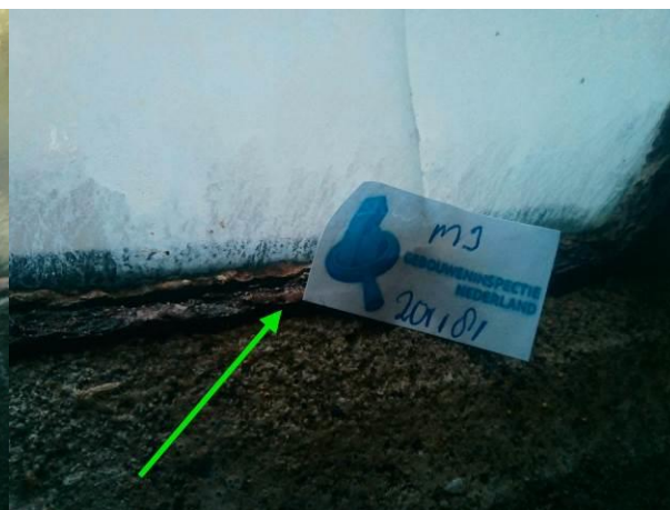
Foto 13 | stopverf / vulpasta in stalen ramen
