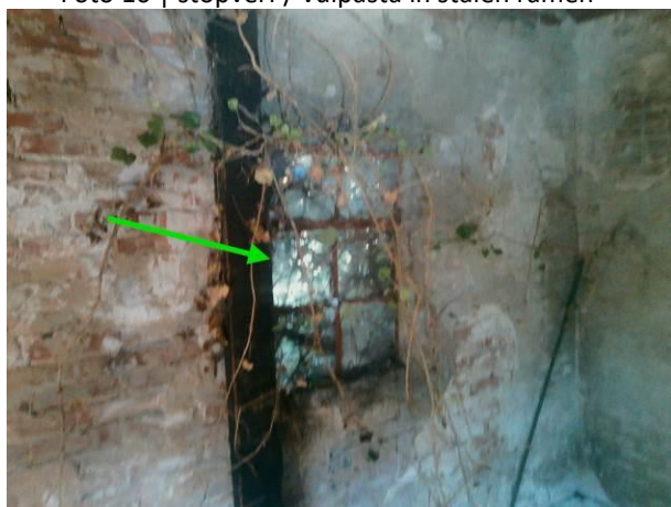
Foto 18 | stopverf / vulpasta in stalen ramen
