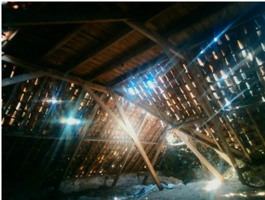
originele kapconstructie achterhuis
