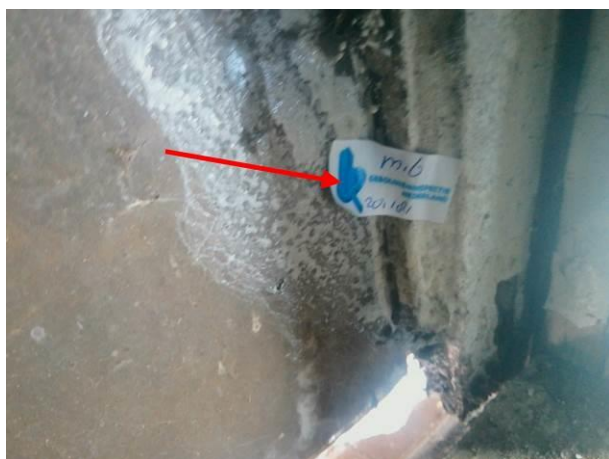
Foto 61 | houten kozijnen met stopverf / vulpasta
