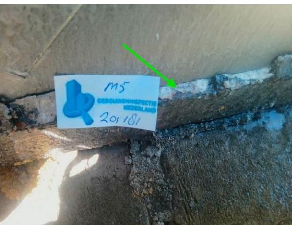
Foto 17 | stopverf / vulpasta in stalen ramen
