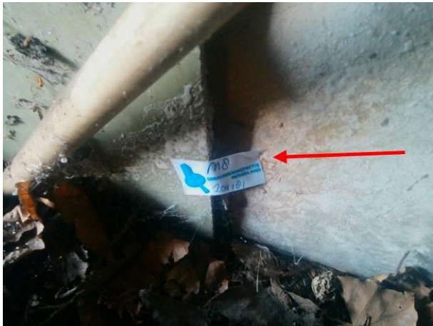
Foto 34 | restanten plaat ingegraven
