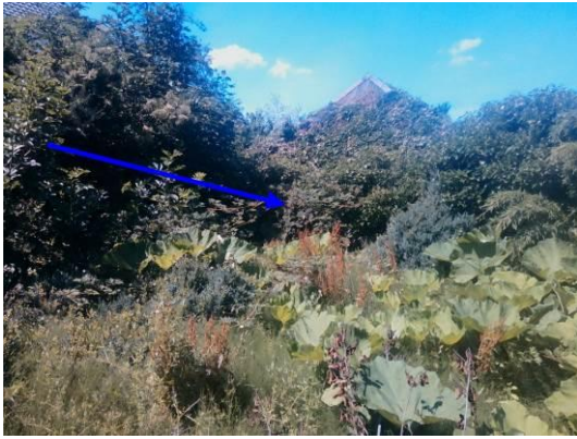
linkerzijde schuur 1 volledig begroeid
