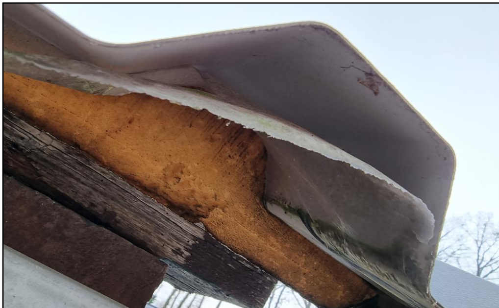
Figuur 6 Aanwezige vogelwering onder het damwandplaten zadeldak van Lage Weide 22.
