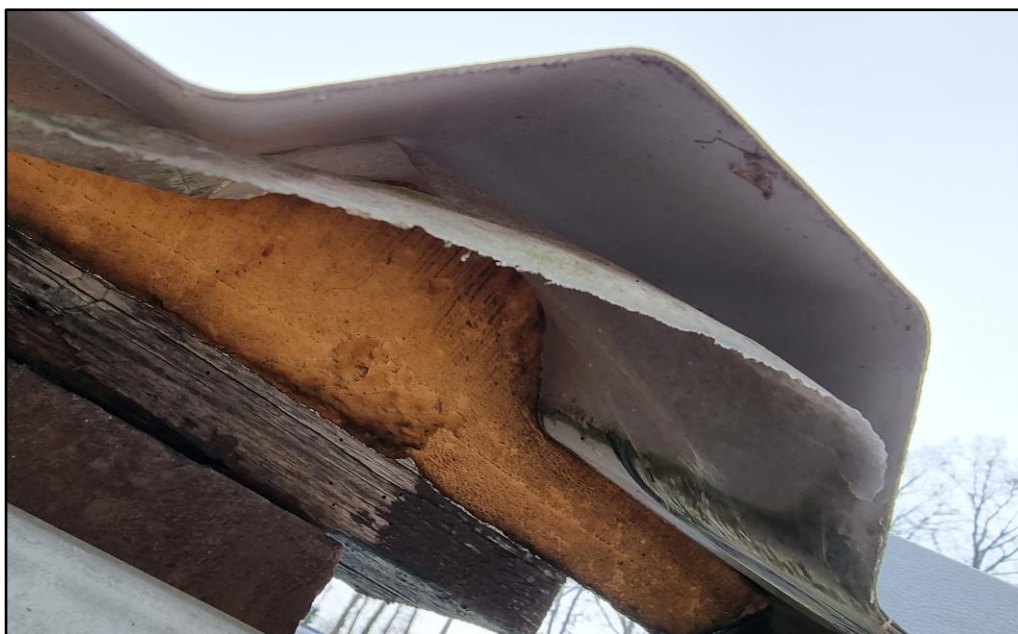
Figuur 6 Aanwezige vogelwering onder het damwandplaten zadeldak van Lage Weide 22.
