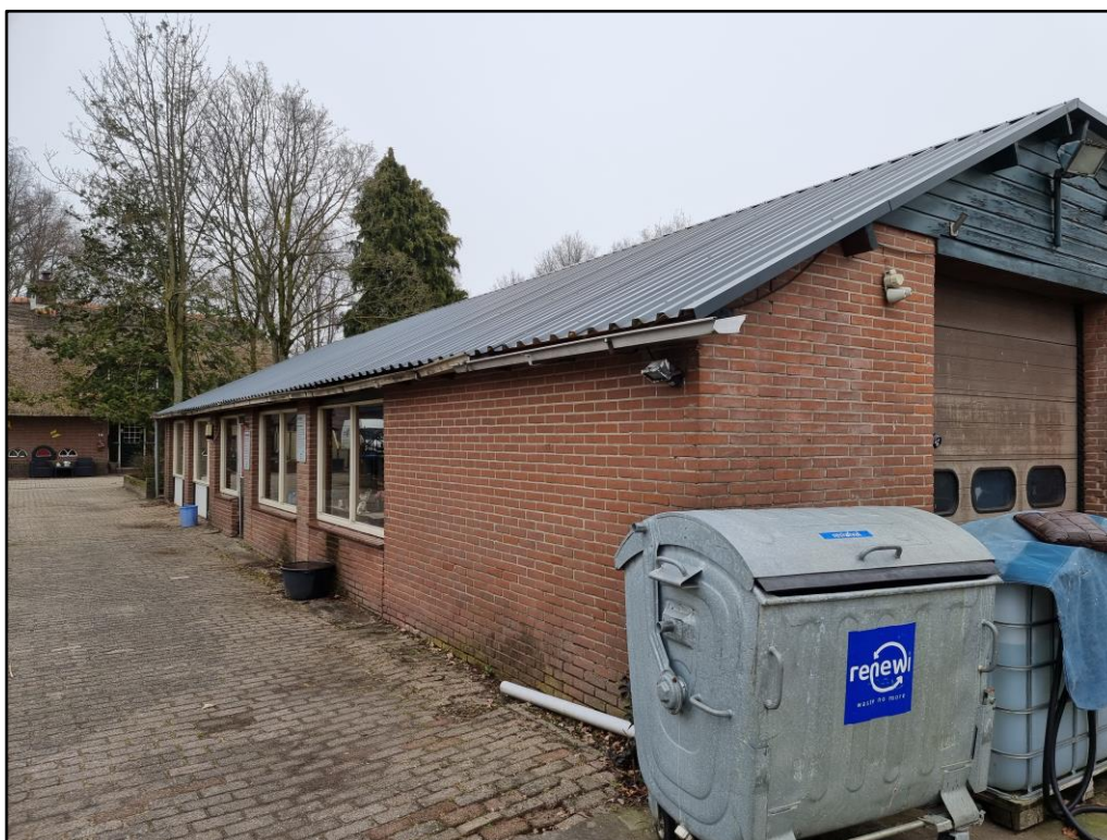
Figuur 2 De garage en woning op de planlocatie zijn direct aan elkaar verbonden en betreffen gemetselde muren en damwandplaten dak.
